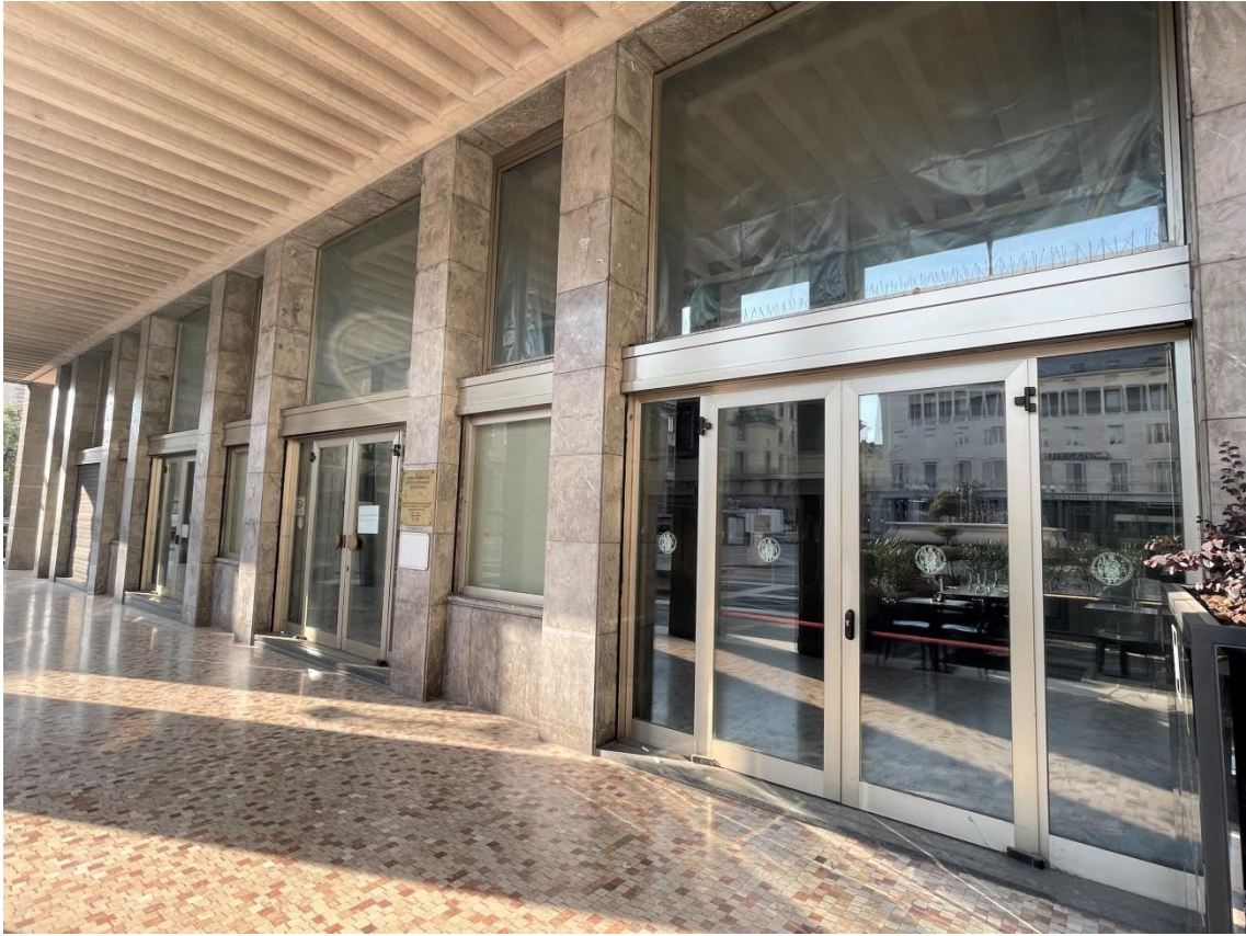
Vista porticato esterno
