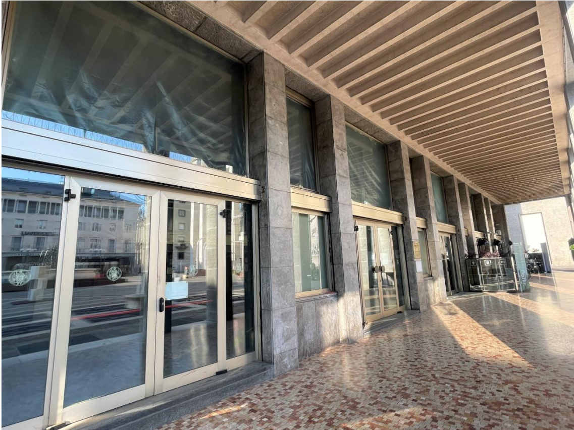
Vista porticato esterno
